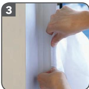
**3** Laisser la fenêtre ouverte. D'abord, fixer le **côté A** le plus large du voile (fermeture éclair fermée) sur l'encadrement en partant du centre vers les côtés droit et gauche et vers le haut et le bas.
