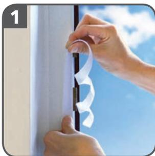
Raam eerst openen en de oppervlakte op het raamkozijn en vleugel reinigen waarop moet worden geplakt, zodat deze stof- en vetvrij zijn. Klitteband openen en klitteband (**Kant A**) op het raamkozijn plakken.
