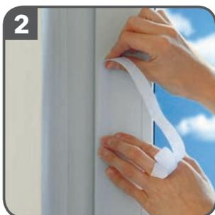
**2** Coller les bandes auto-agrippantes (**côté B**) au choix sur le côté **a**) extérieur ou **b**) intérieur de la fenêtre (côté poignée). Veiller à ce que la fenêtre puisse se fermer.
