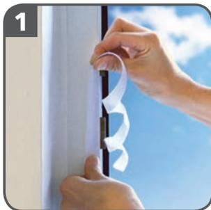
1 Aprire la finestra e pulire per bene l'anta e il telaio della finestra dove applicare la guarnizione, eliminando polvere e grasso. Aprire la chiusura a strappo e far aderire il nastro adesivo (**lato A**) al telaio della finestra. **Non attaccare lo strappo sulla superficie di contatto tra telaio e anta (la finestra si deve poter chiudere normalmente anche se la guarnizione è montata)!**
