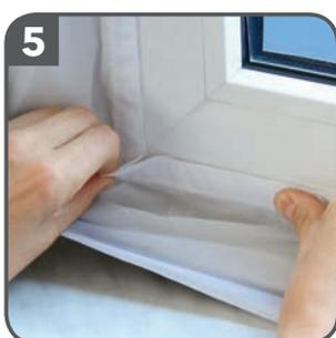
**5** Fixer le côté le plus étroit **B** (fermeture éclair fermée) sur le battant de fenêtre en partant du centre vers les côtés droit et gauche et vers le haut et le bas.
