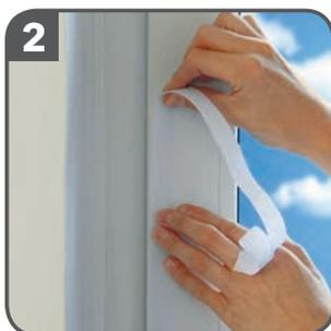
2 Attaccare il nastro adesivo (**lato B**) sul lato **a)** esterno o **b)** interno dell'anta della finestra (lato con la maniglia).
